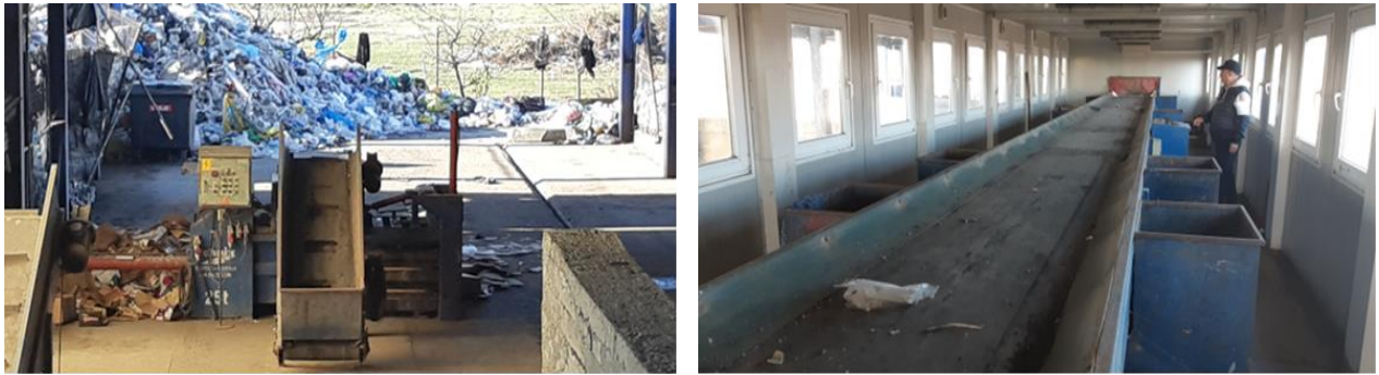
Figura 4.11. Stația de sortare a reciclabilelor Drăgășani
