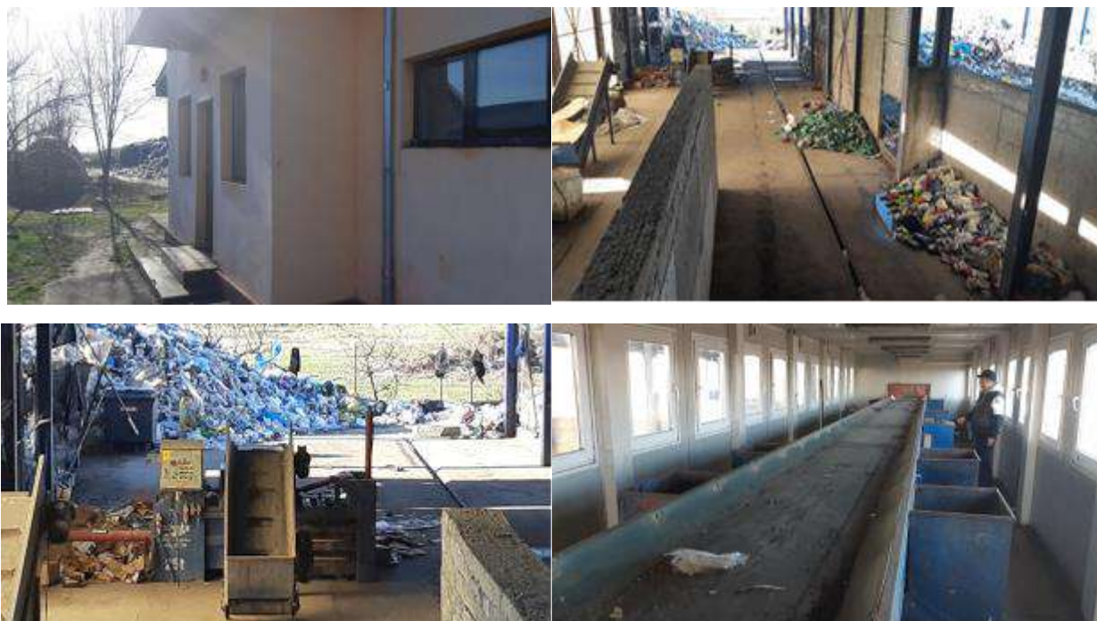
Figura 4.11. Stația de sortare a reciclabililor Drăgășani
