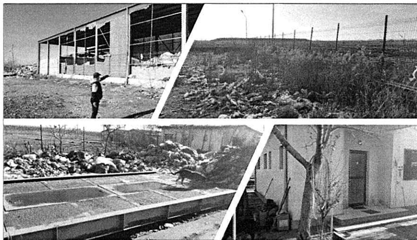
Figura 4-13: Infrastructura stației de sortare Drăgășani
